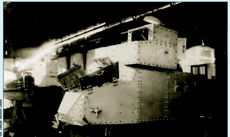
Foto 8: Renault TSF sendo restaurado juntamente com um modelo ao fundo, com torre octogonal rebitada, na Oficina Ferroviária de Engenho de Dentro em 1932, quando, após a extinção da Companhia de Carros-de-Assalto em janeiro, ela é reativada em julho daquele ano em virtude da Revolução Constitucionalista deflagrada por São Paulo. O TSF não chegou a ficar operacional
