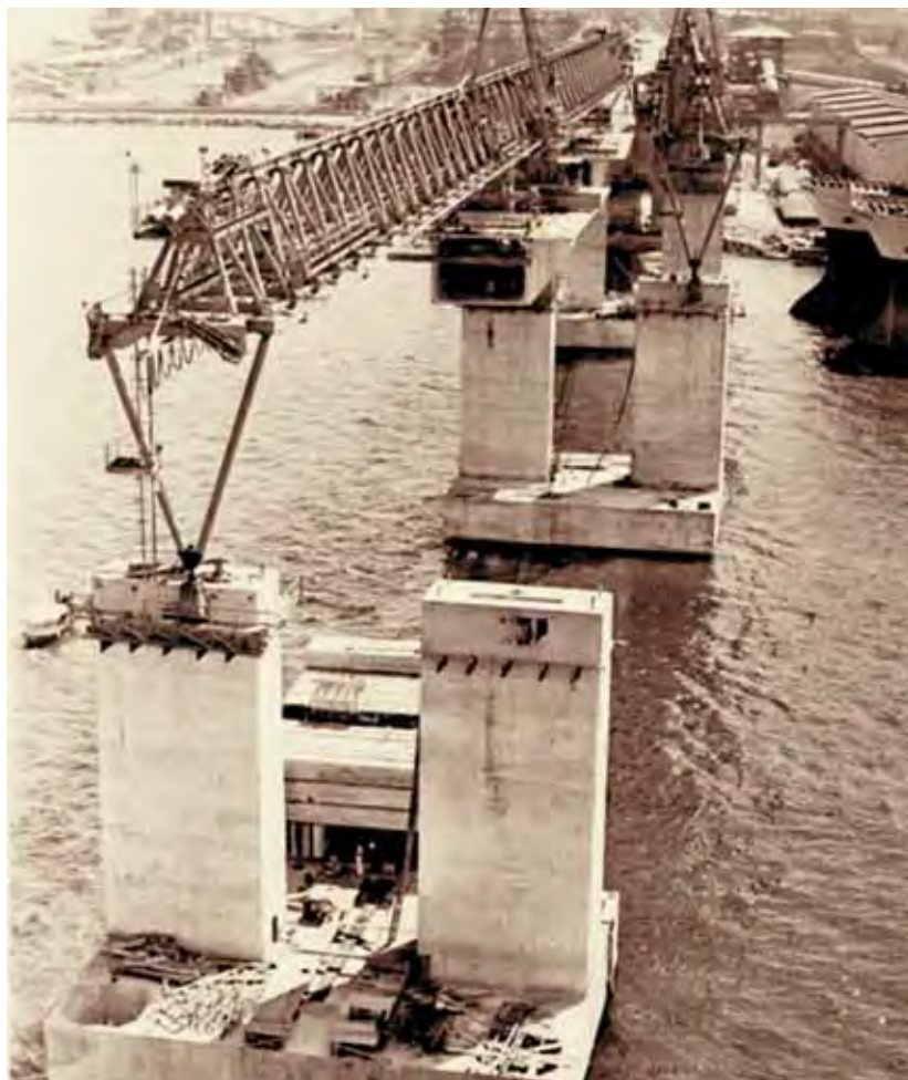
Montagem do caixão de um vão, com aduelas.
