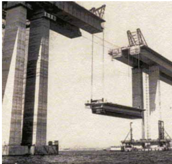
Alçando unidade metálica extrema, de 44m.
