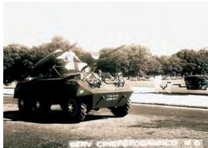
Lançador de foguetes rotativo acoplado à torre de um M-8 Greyhound 6x6, desenvolvida pelo IME, desfilando em 28 de junho de 1966. (Foto: Exército Brasileiro)
